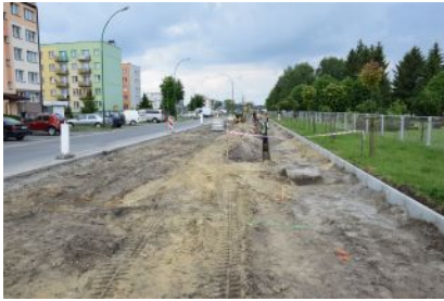
Prace na ul. Jana Pawła II
