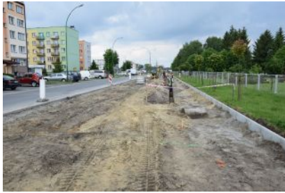
Prace na ul. Jana Pawła II
