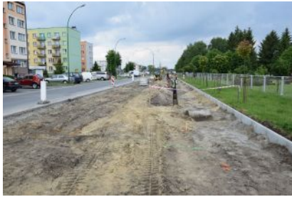
Prace na ul. Jana Pawła II
