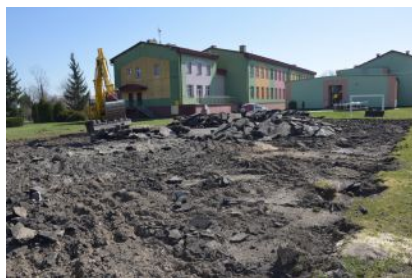
Budowa boiska w Kolbuszowej Górnej
