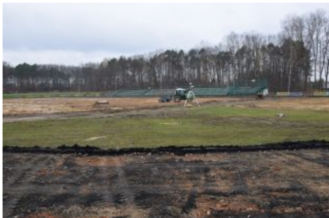
Przebudowa stadionu w Kolbuszowej
