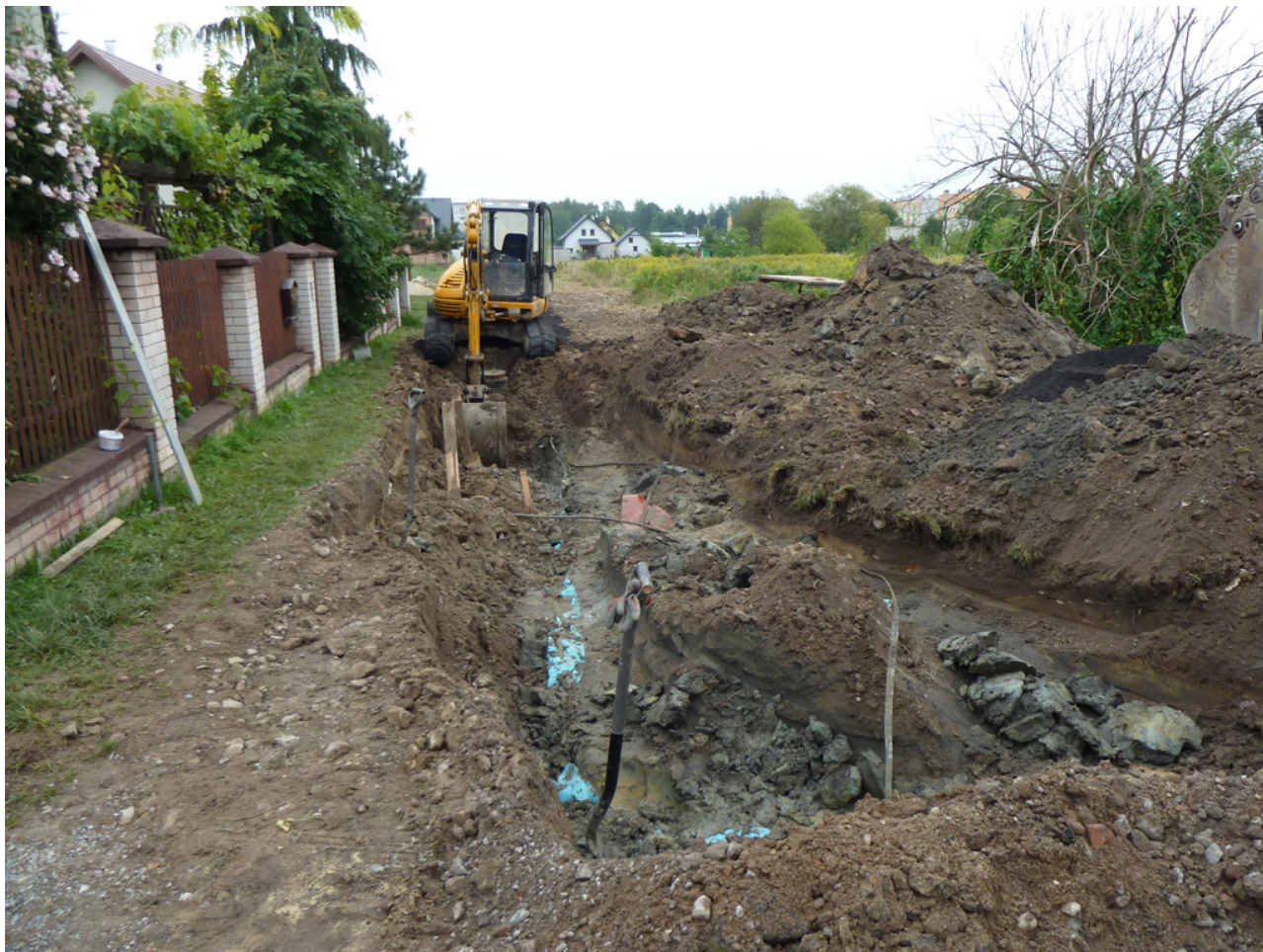
Budowa Kanalizacji- Kolbuszowa Górna
