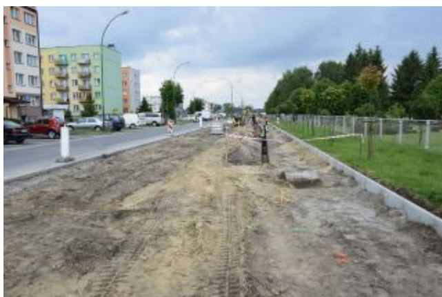
Prace na ul. Jana Pawła II
