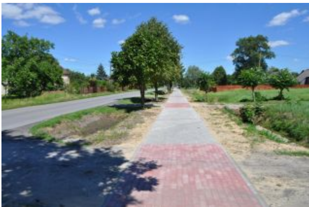
Budowa chodnika w Kupnie
