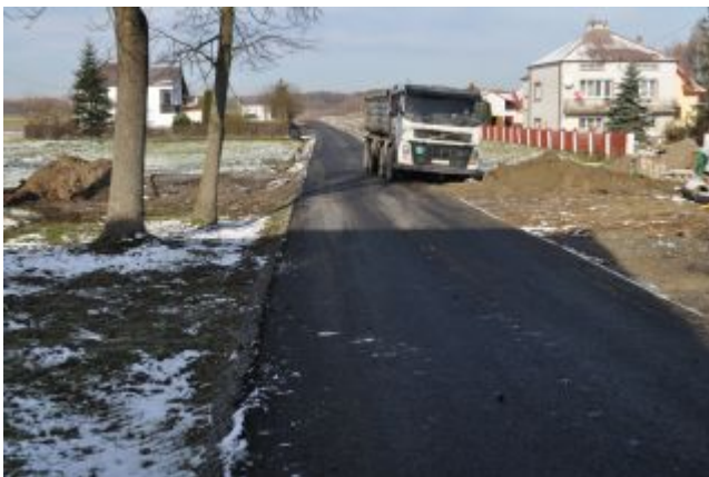
Przebudowa dróg gminnych
