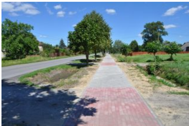
Budowa chodnika w Kupnie
