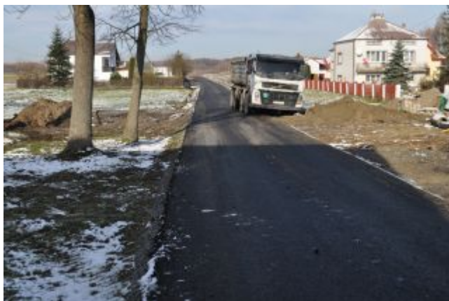
Przebudowa dróg gminnych
