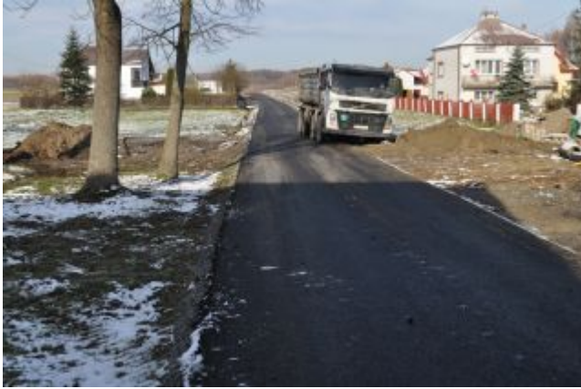
Przebudowa dróg gminnych
