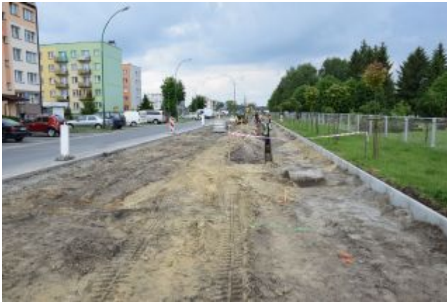
Prace na ul. Jana Pawła II
