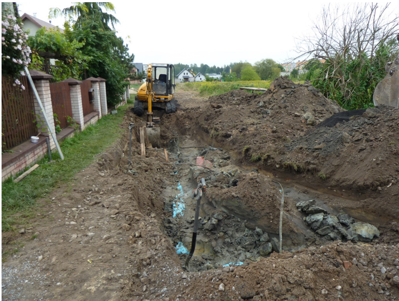
Budowa Kanalizacji- Kolbuszowa Górna
