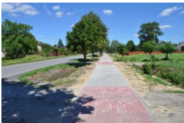
Budowa chodnika w Kupnie
