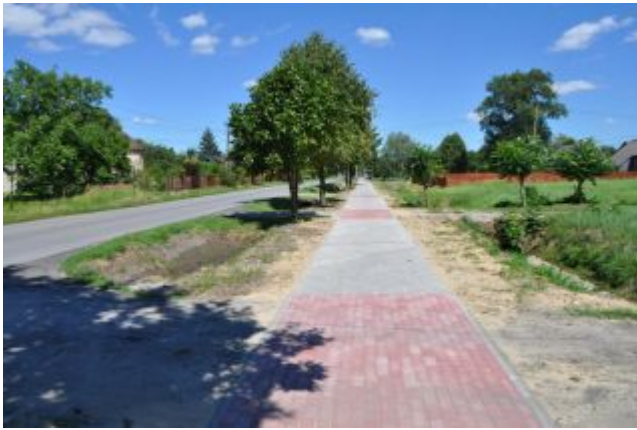
Budowa chodnika w Kupnie
