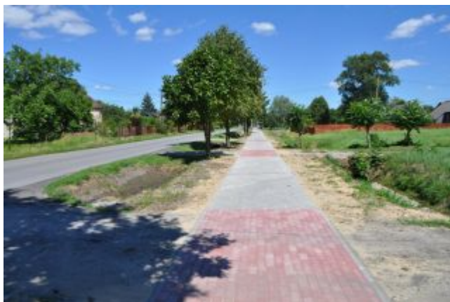
Budowa chodnika w Kupnie
