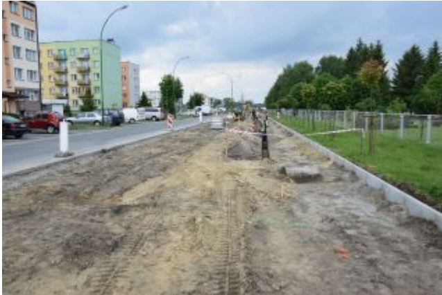
Prace na ul. Jana Pawła II
