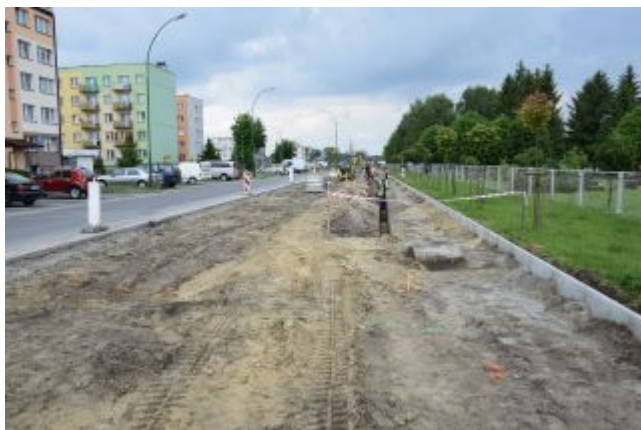
Prace na ul. Jana Pawła II
