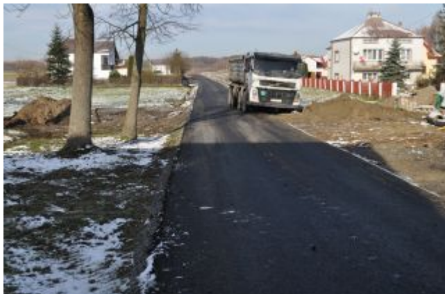
Przebudowa dróg gminnych
