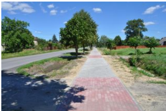
Budowa chodnika w Kupnie
