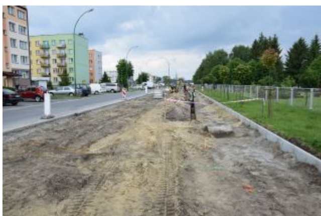
Prace na ul. Jana Pawła II
