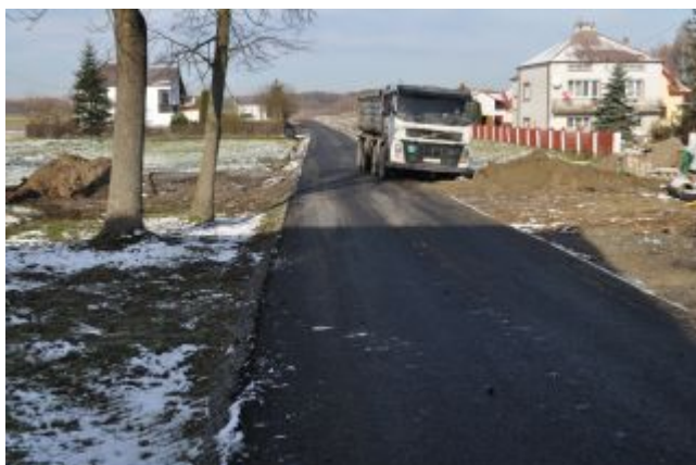
Przebudowa dróg gminnych
