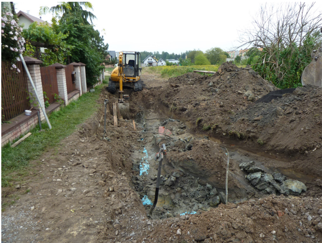
Budowa Kanalizacji- Kolbuszowa Górna
