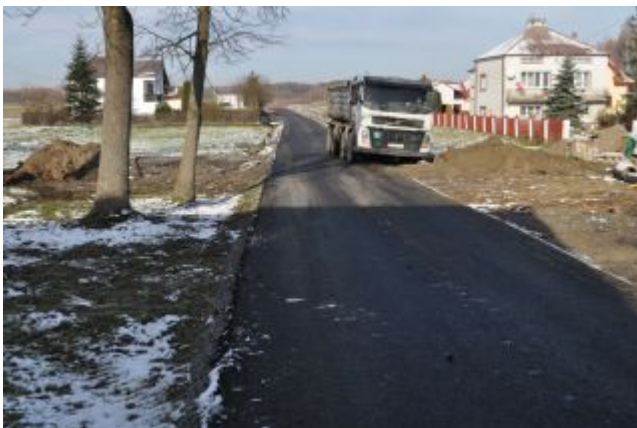
Przebudowa dróg gminnych
