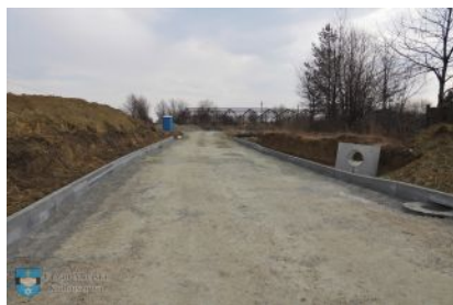
Budowa nowego odcinka drogi w Kolbuszowej
