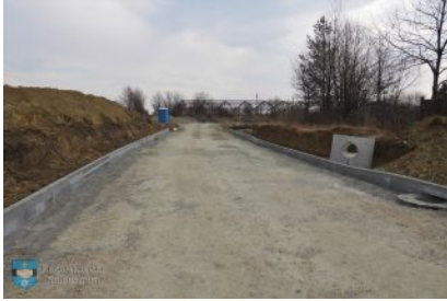
Budowa nowego odcinka drogi w Kolbuszowej
