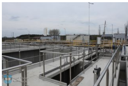
Rozbudowa oczyszczalni ścieków w Kolbuszowej Dolnej
