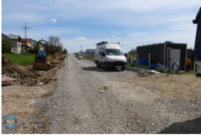
Ul. Przemysłowa i Żytnia w przebudowie
