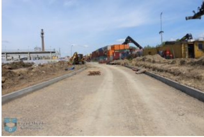
Roboty budowlane przy ul. Wiktora i ul. ks. Ruczki
