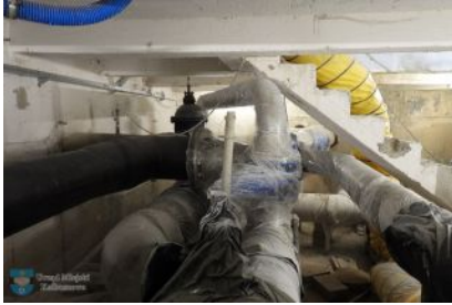
Remont zbiorników przy ul. Przemysłowej
