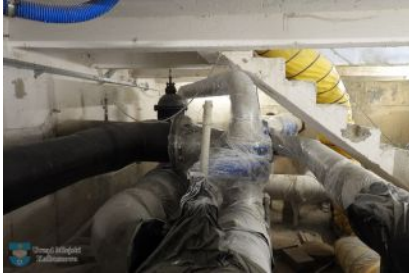
Remont zbiorników przy ul. Przemysłowej
