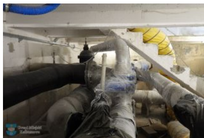
Remont zbiorników przy ul. Przemysłowej
