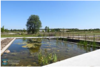
II etap budowy Parku Niepodległości
