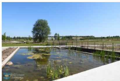
II etap budowy Parku Niepodległości
