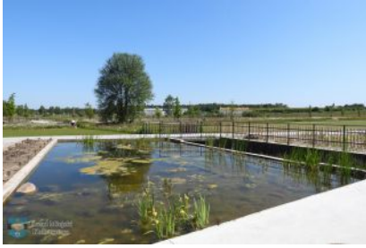
II etap budowy Parku Niepodległości
