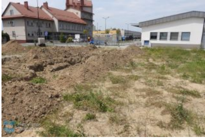
Budowa parkingu obok stacji kolejowej w Kolbuszowej
