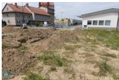
Budowa parkingu obok stacji kolejowej w Kolbuszowej
