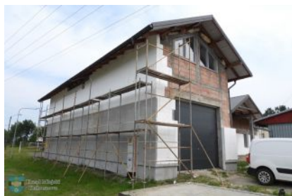
Budowa remizy w Świerczowie
