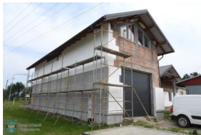
Budowa remizy w Świerczowie
