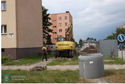
Budowa kanalizacji w gminie
