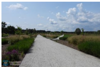
II etap budowy Parku Niepodległości w Kolbuszowej
