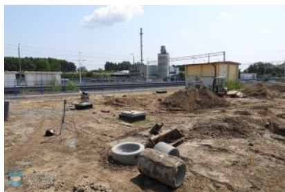
Budowa parkingu przy dworcu
