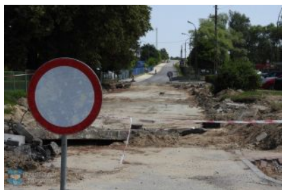
Przebudowa ul. Żytniej i Przemysłowej
