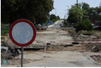
Przebudowa ul. Żytniej i Przemysłowej
