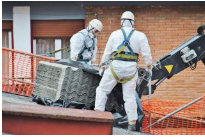
Odbiór odpadów niebezpiecznych zawierających azbest
