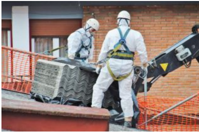
Odbiór odpadów niebezpiecznych zawierających azbest
