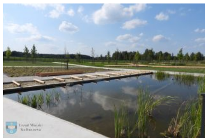
Prace w Parku Niepodległości
