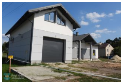
Nowy budynek remizy OSP w Świerczowie
