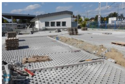
Budowa parkingu w Kolbuszowej
