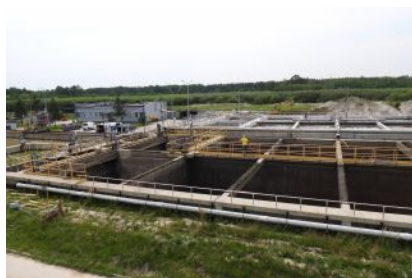
Rozbudowa i modernizacja oczyszczalni ścieków w Kolbuszowej Dolnej - etap I
