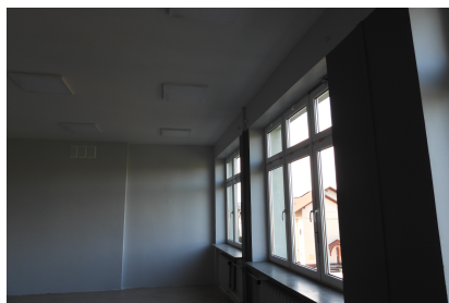
Wakacyjny remont w PP Nr 2
