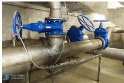
Remont zbiorników przy ul. Przemysłowej
