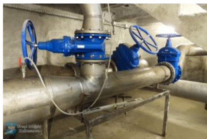
Remont zbiorników przy ul. Przemysłowej
