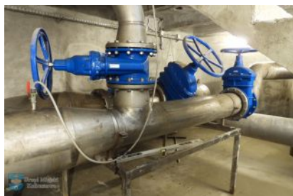
Remont zbiorników przy ul. Przemysłowej
