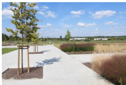
Budowa Parku Niepodległości
