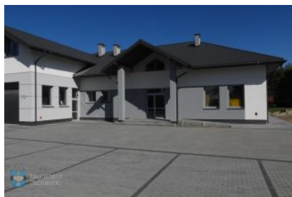
Remiza w Świerczowie na ukończeniu
