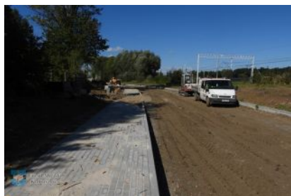
Prace przy połączeniu ul. Ruczki i Wiktora
