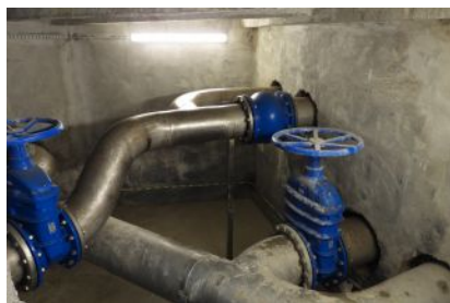
Remont zespołu zbiorników na wodę przy ul. Przemysłowej
