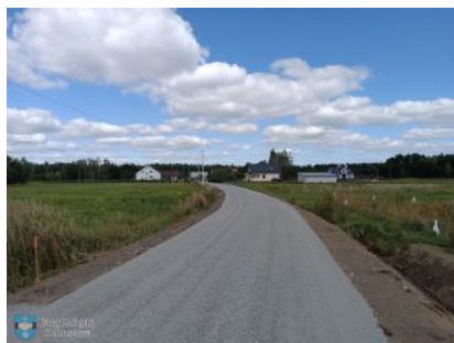
Modernizacja drogi gminnej w Nowej Wsi
