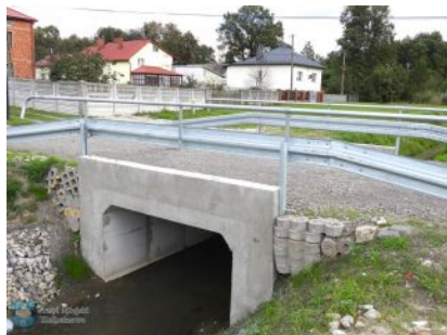
Odbudowa przepustów drogowych w Widełce
