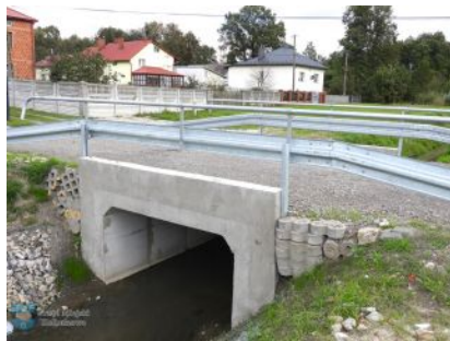
Odbudowa przepustów drogowych w Widełce
