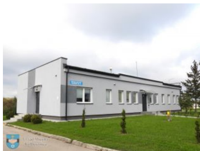
Zakończono I etap rozbudowy i modernizacji oczyszczalni ścieków
