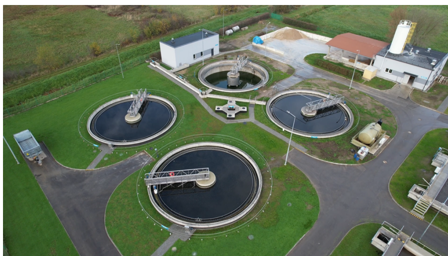
Zakończono budowę i modernizację oczyszczalni ścieków w Kolbuszowej Dolnej
