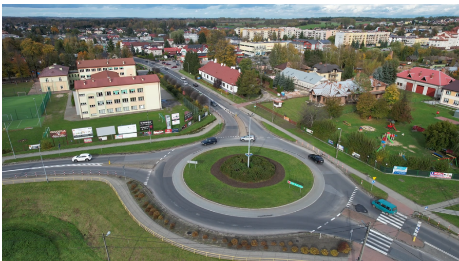
Na ul. Kosciuszki zbudowane zostanie oświetlenie uliczne
