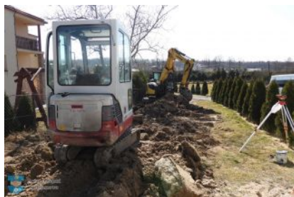
Budowa kanalizacji w Weryni - etap II cz. 2
