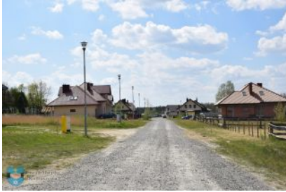
Przebudowa dróg gminnych
