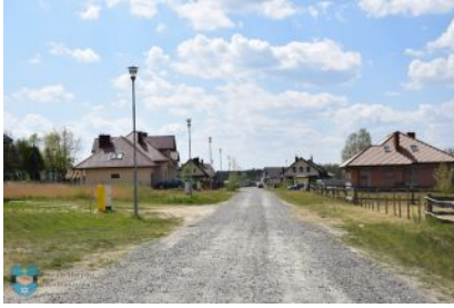
Przebudowa dróg gminnych
