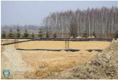
Budowa domu przedpogrzebowego
