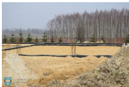
Budowa domu przedpogrzebowego
