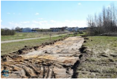
Rozbudowa ul. Błonie w Kolbuszowej
