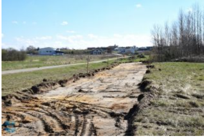
Rozbudowa ul. Błonie w Kolbuszowej
