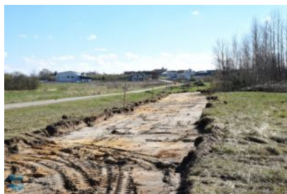
Rozbudowa ul. Błonie w Kolbuszowej
