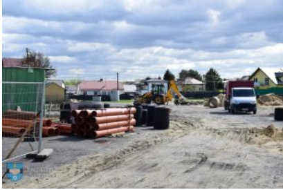
Budowa placu targowego w Kolbuszowej
