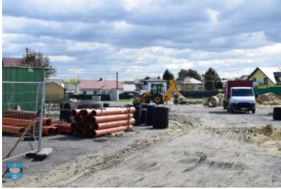
Budowa placu targowego w Kolbuszowej
