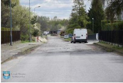
Przebudowa ul. 3 Maja w Kolbuszowej
