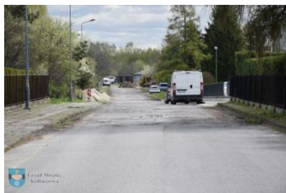
Przebudowa ul. 3 Maja w Kolbuszowej
