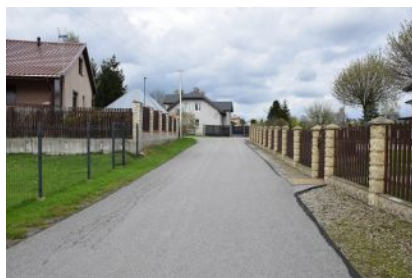
Budowa kanalizacji na ul. Południowej
