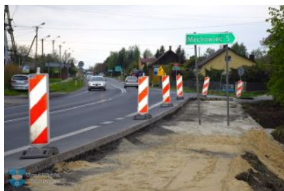
Budowa chodnika na odcinku Zarębki-Kolbuszowa Dolna
