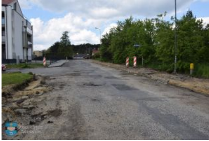
Postęp prac na ul. 3 Maja w Kolbuszowej
