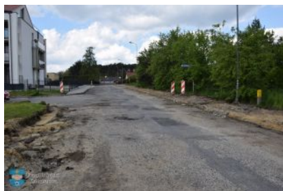
Postęp prac na ul. 3 Maja w Kolbuszowej
