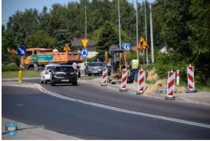
Przebudowa oświetlenia na ul. Kościuszki
