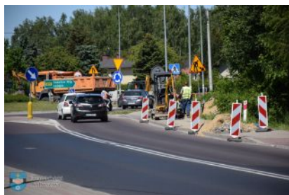
Przebudowa oświetlenia na ul. Kościuszki
