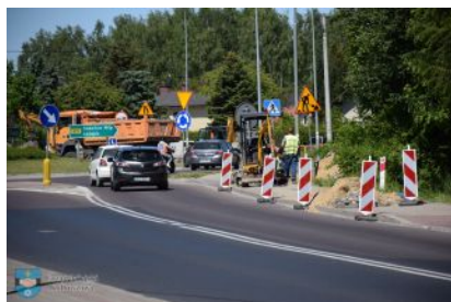
Przebudowa oświetlenia na ul. Kościuszki
