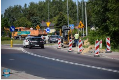
Przebudowa oświetlenia na ul. Kościuszki
