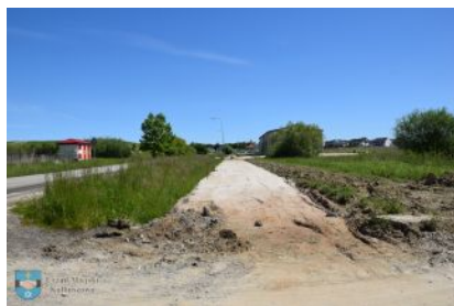
Postęp prac na ul. Błonie
