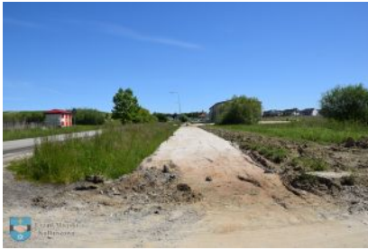
Postęp prac na ul. Błonie
