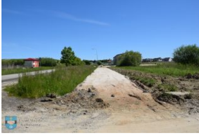
Postęp prac na ul. Błonie
