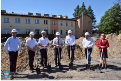
Budowa hali sportowej w Przedborzu
