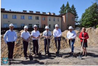
Budowa hali sportowej w Przedborzu
