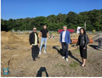
Trwa budowa placu targowego w Kolbuszowej
