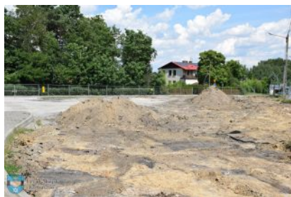
Budowa parkingu przy stadionie miejskim
