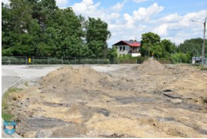
Budowa parkingu przy stadionie miejskim
