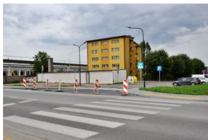
Zakończenie robót na ul. Kolejowej
