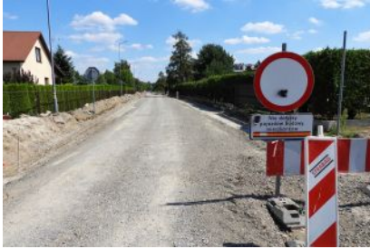
Przebudowa ul. 3 maja
