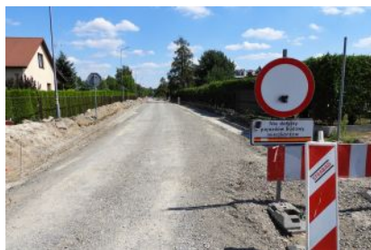
Przebudowa ul. 3 maja
