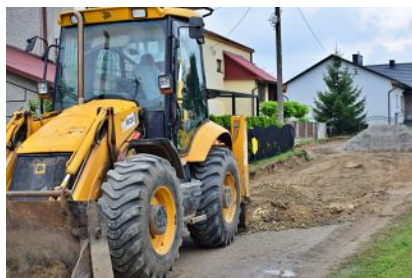
Przebudowa ul. Skowrońskiego w Kolbuszowej
