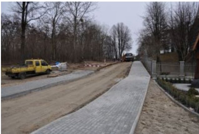
Budowa chodnika w miejscowości Kupno
