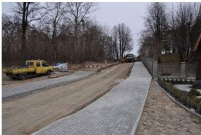
Budowa chodnika w miejscowości Kupno
