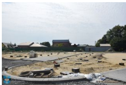
Budowa placu targowego
